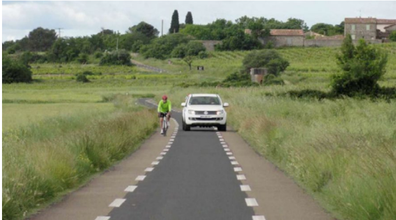
Exemple (Département de l'Hérault) de réduction visuelle de chaussée, avec marquage de continuités cyclables et piétonnes, en bordure d'une route rurale. Cette intervention minimale permet à la fois d'indiquer la priorité des modes doux sur les voitures et de faire ralentir les automobilistes, qui se voient contraints de ralentir et de se céder le passage pour se croiser, le tube central étant réduit à la largeur d'une seule voie (3 à 4 mètres).
